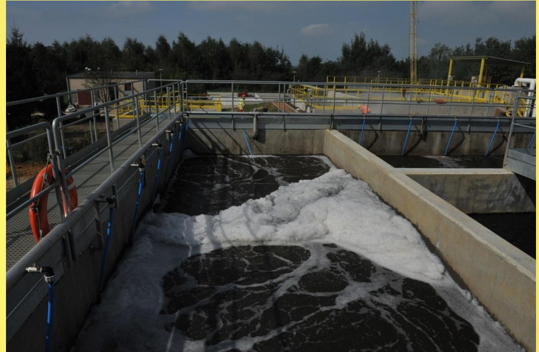
Modernizacja oczyszczalni ścieków i budowa kanalizacji sanitarnej w gminie Baranów Sandomierski
