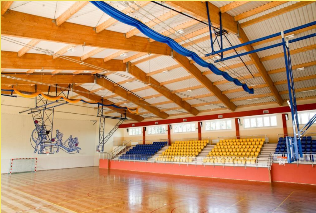
Budowa hali sportowej w Błażowej.
